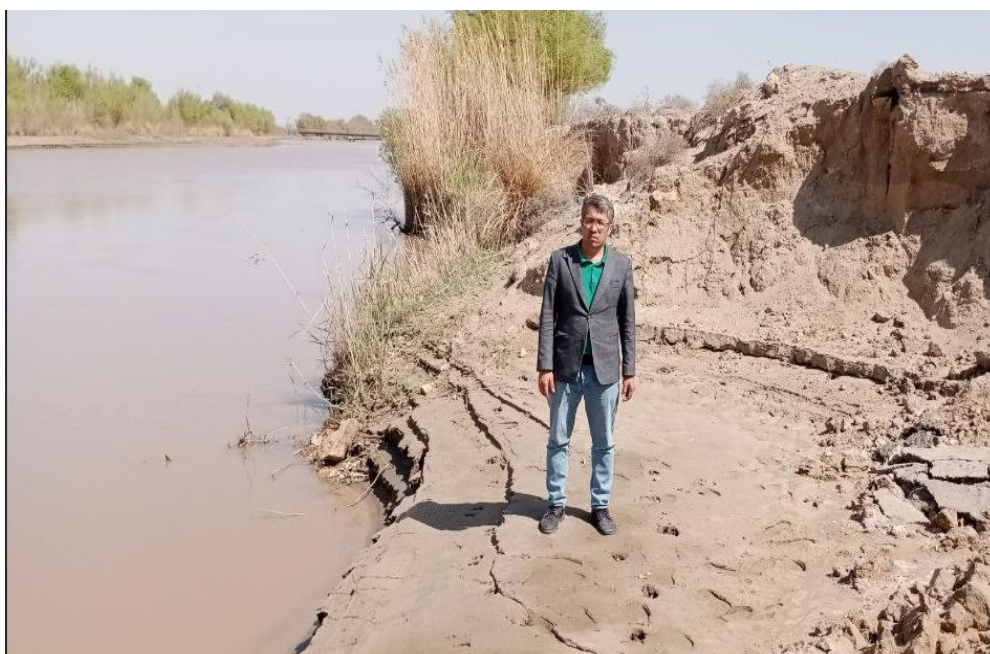
2-rasm. Amu-Buxoro mashina kanali PK1099 piketida yuvilish holati.
